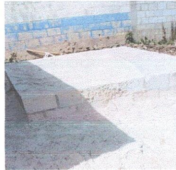
Foto 2: Mejoramiento de fosa septica
