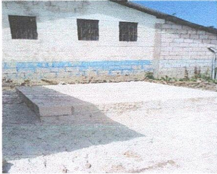
Foto1: Mejoramiento de Fosa septica
