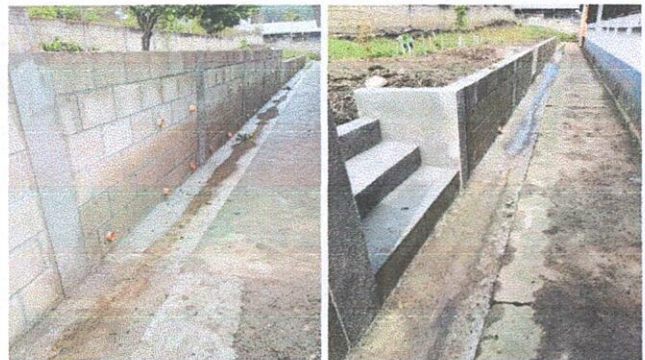
Foto 4: Mejoramiento de cuneta y muro de contención
